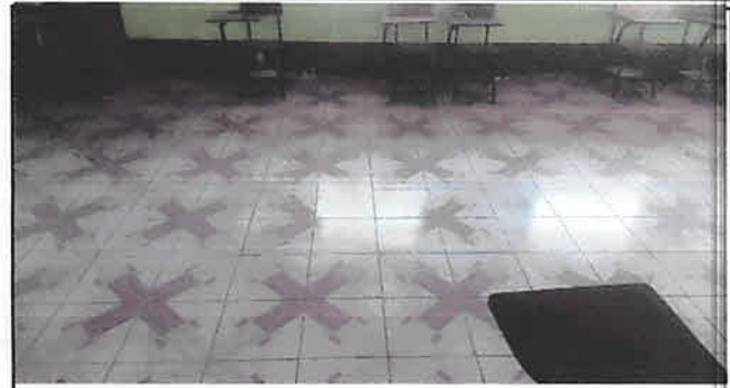
Foto 2: Reparación de piso de cemento por piso cerámico
