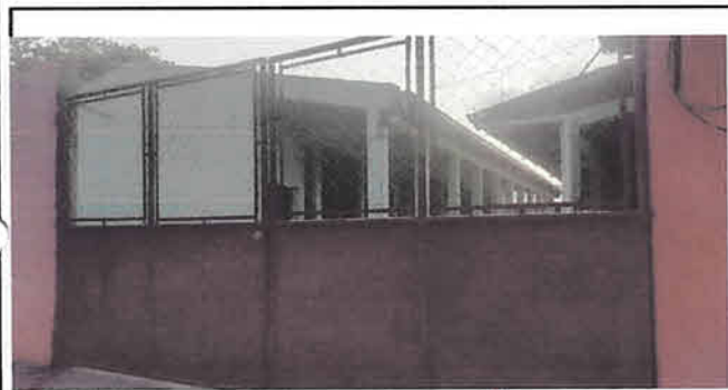
Foto 5: Reparación de porton de ingreso a la Escuela.
