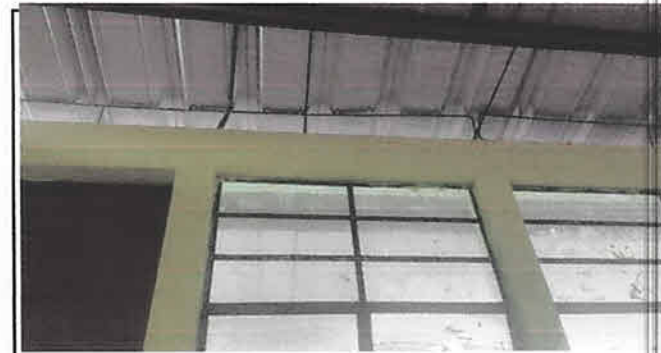
Foto 4: Instalación y reparación de arnes
