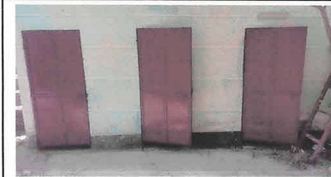
Foto 1: Lijado de puertas y pared de sanitarios
